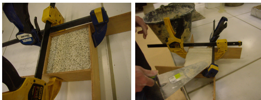
Figure 2. Mise en œuvre des enduits.
